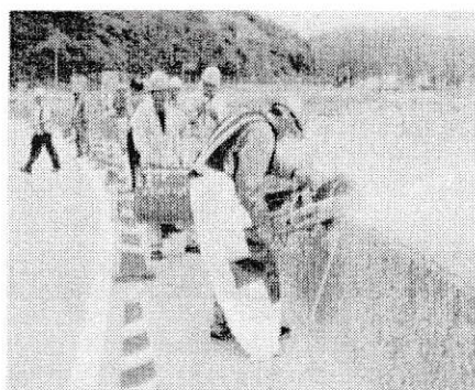
作業員がコンクリートカッターで護岸を切り、工事が始まった塩屋湾外海埋め立て事業 ＝大宜味村塩屋
