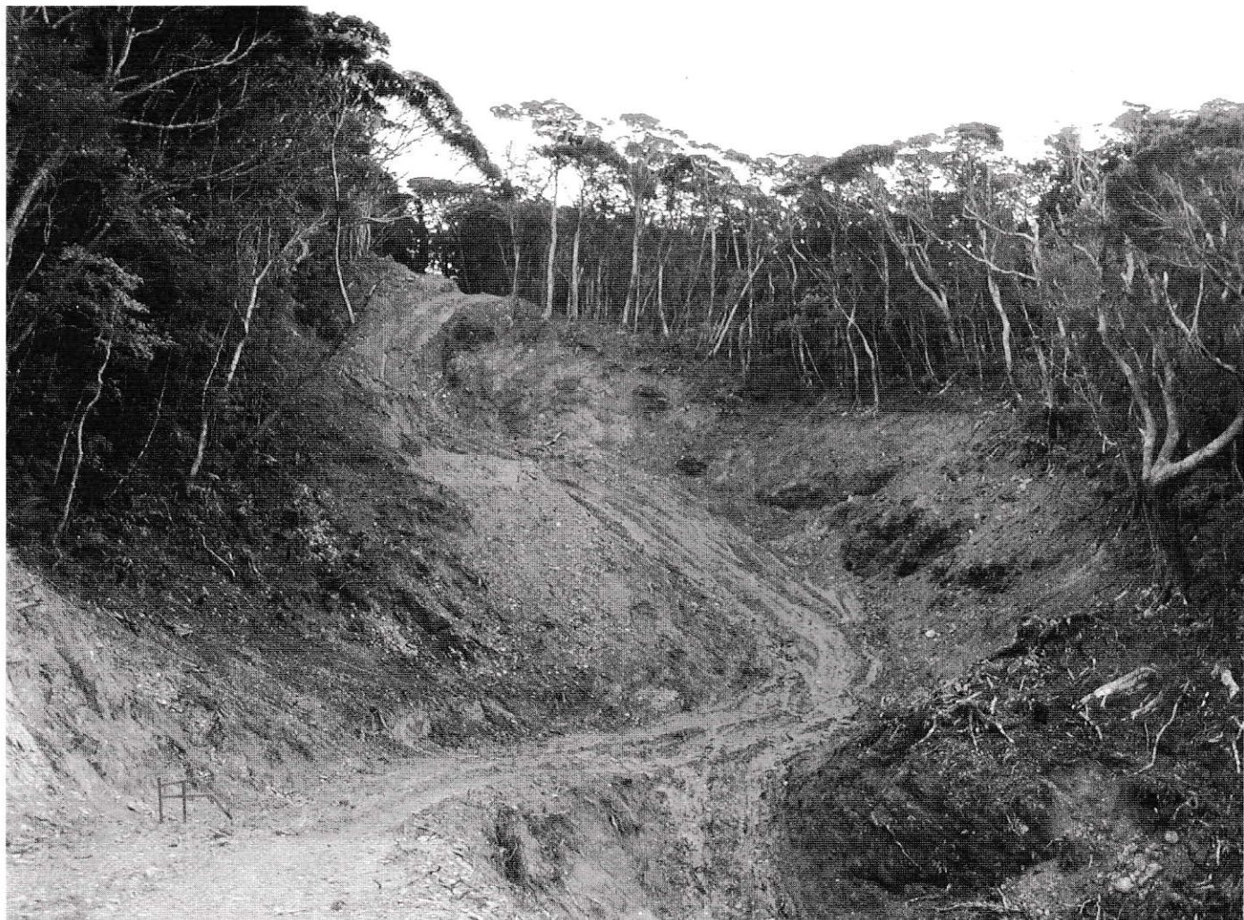
建設中の国頭村・謝敷林道（2003年）
