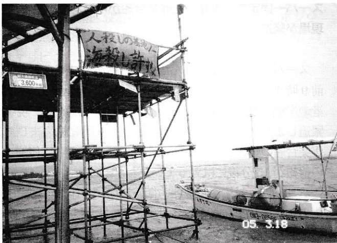
第二ポイントの足場
