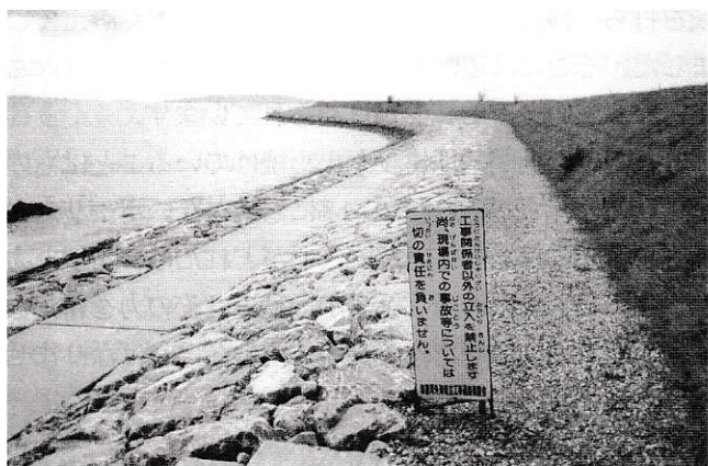
あまりに巨大な埋立て現場
