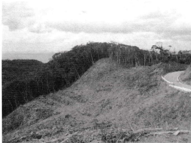
謝敷林道の皆伐現場（2006年1月）
