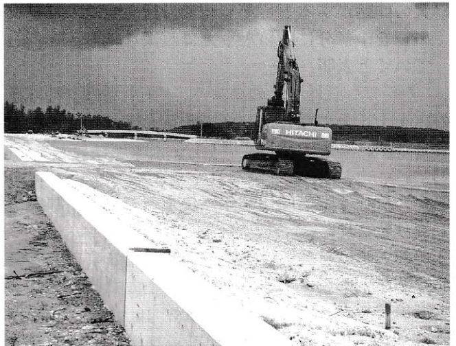
養浜工事の進む済井出浜（2010年9月）
